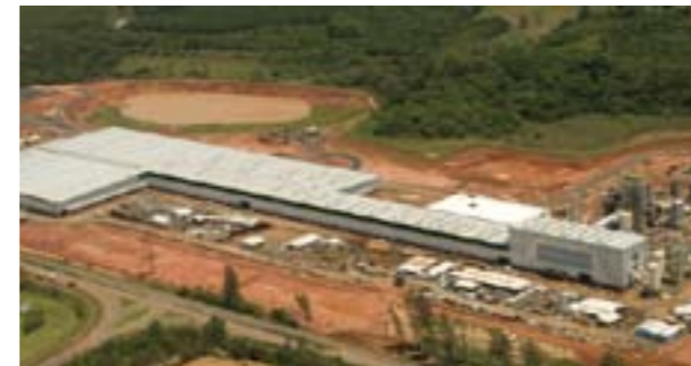
Construcción de Planta MDP - Brasil
